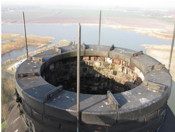
De bovenkant van de schoorsteen met de vier bliksemafleiders en de metalen rand.
