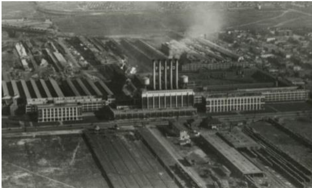
[De grote elektriciteitscentrale van Ford Highland Park]
